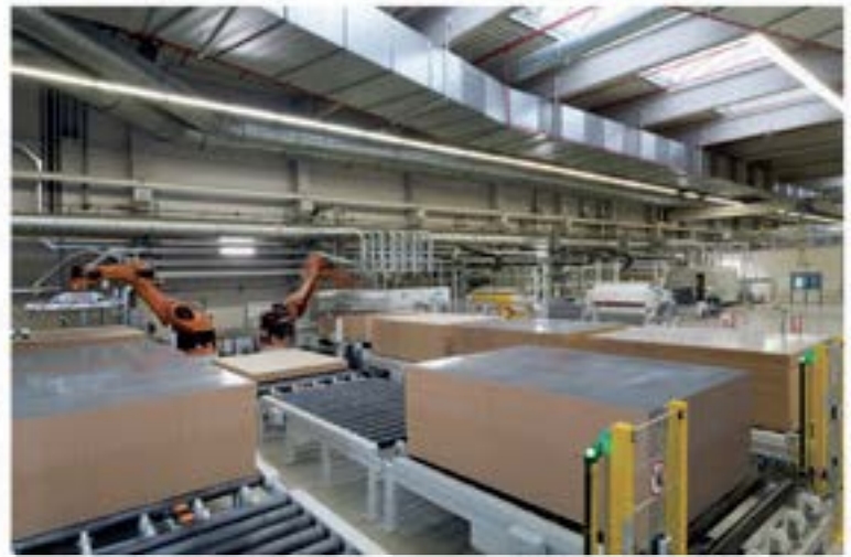
Fig. 5 | Vista desde la unidad de alimentación a la sala limpia (© EGGGER) Fig. 5. View from the feeding unit to the clean room (© EGGGER) Fig. 5. Vista da unidade de alimentação para a sala limpa (© EGGGER)
