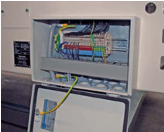
Eingebaut in standardisierte Verteilerkästen an der Maschine, unterstützen die ZIA-Reihenklemmen zeitsparende Auf- und Umbauarbeiten bei Hymmen
